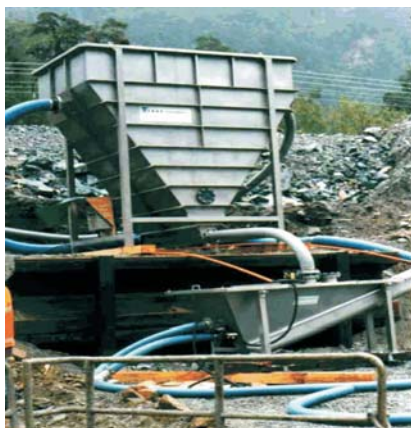
Устройство осаждения, тип DCS, на строительстве тоннеля очищенные стоки используются как вода для охлаждения
